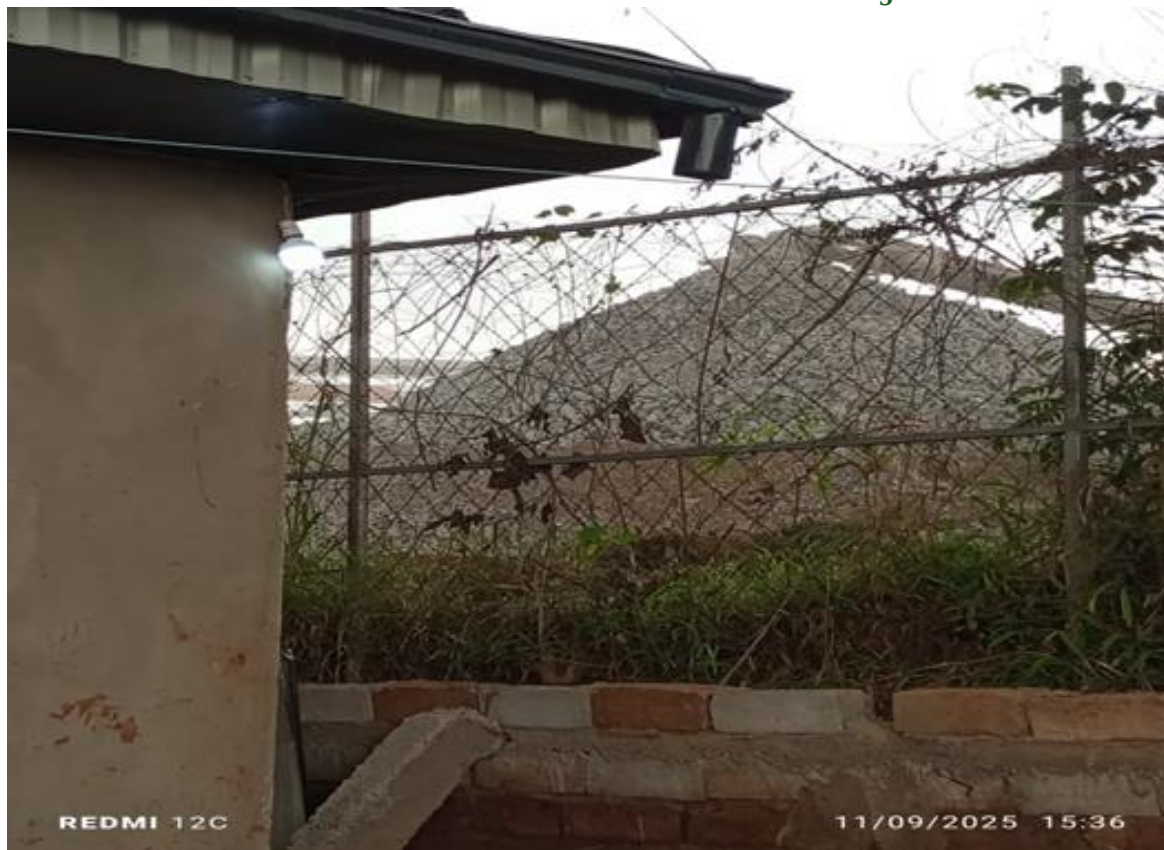
Figure 16 — Maison habitée à moins de 10 mètres de la machine à concassage d'une carrière industrielle
